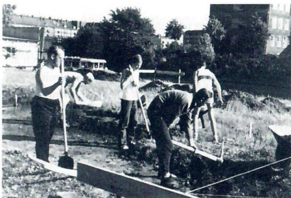
Die Ausschachtungsarbeiten beginnen. Mit Hacke und Spaten wird das Fundament vorbereitet.
